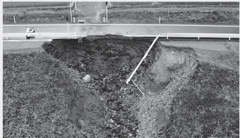
7月10日の大雨で築堤崩壊した「BRTひこぼしライン」(筑前岩屋・大行司間)
