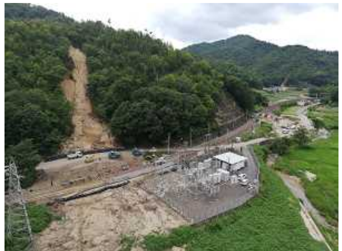
▲2019年に発生した西日本豪雨では山からの土砂・倒木が鉄道施設に流入し、大きな被害となった。
