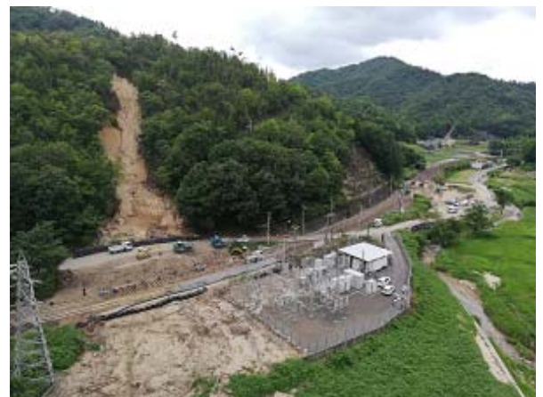
▲八本松変電所は山からの土砂によって流された。
