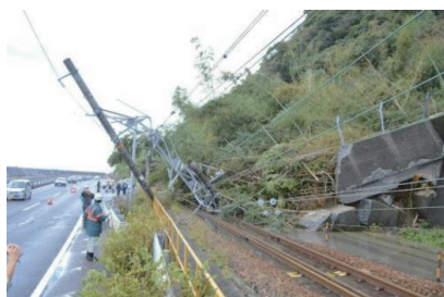
【図表3】JR東海・東海道本線（由比～興津駅間）：台風18号による鉄道被災（2014.10）
