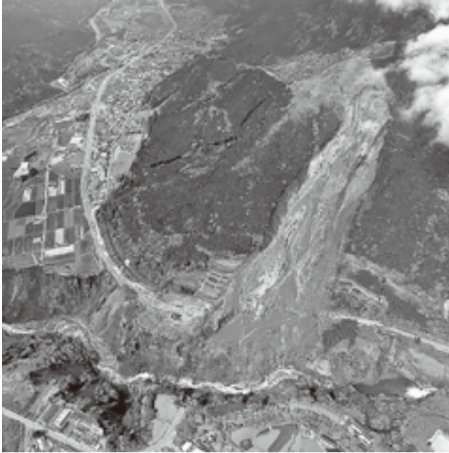
地震による大規模な土砂崩れ（阿蘇大橋付近）
