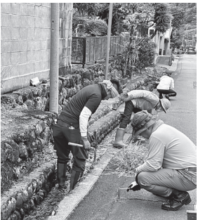
集落を囲むせき (側溝) を整備する参加者
