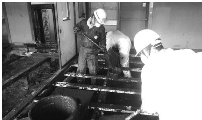
被災者宅で、床下の堆積したヘドロを撤去する
