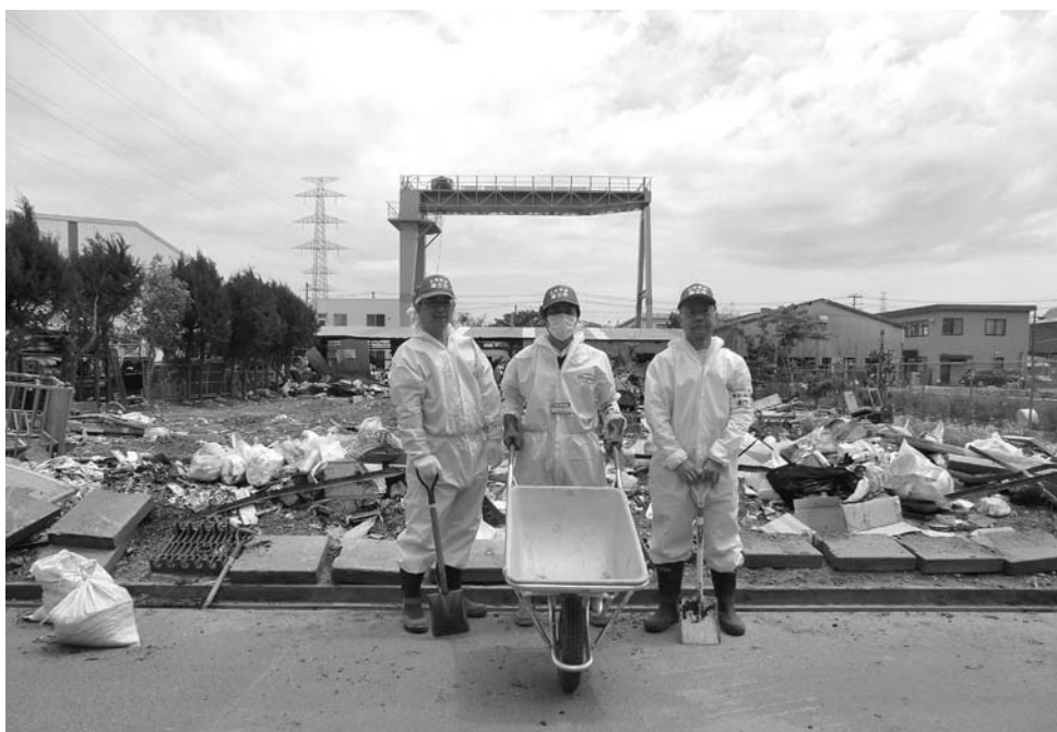
側溝のふたを上げて泥出し作業を行う
