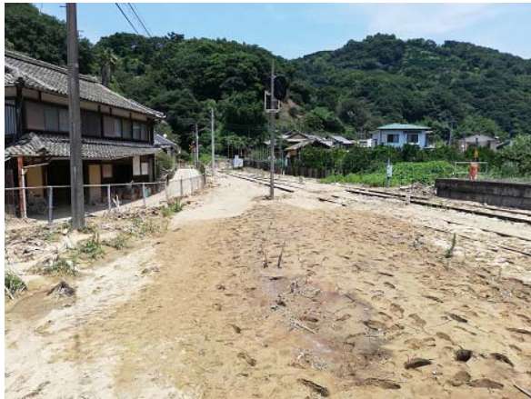
▲伊予吉田駅構内は泥に埋もれ線路が見えなくなっていた
