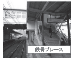
鉄骨ブレースによる耐震補強
