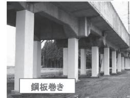
鋼板巻きによる耐震補強
